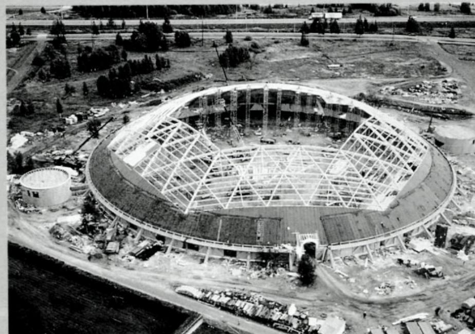
Oulu-Dome, Finnland: Binder aus Furnierschichtholz für eine Kuppel von 115m Durchmesser
