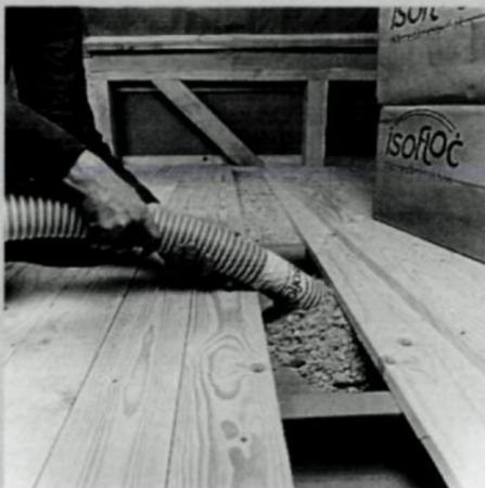
Rationeller Einsatz von Dämmmaterial: Zellulosedämmwolle wird lückenlos in Decken-, Dach- und Wandhohlräume eingeblasen
