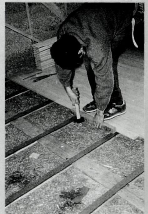
Hanf als Baumaterial: Dämmschüttung zwischen Deckenbalken, Wände aus Hanf-Kalk-Gemisch in einem Haus in der Nähe von Tours (Arch. F.Aujames)
