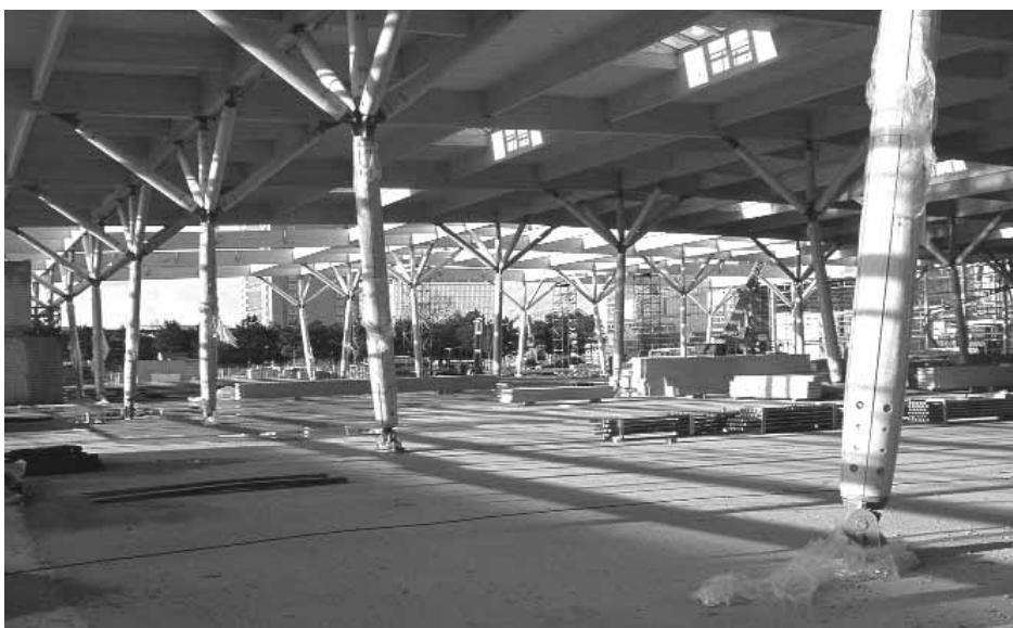
Von der vorgesehenen völligen Verglasung des Daches sind nur einige Oberlichter zurückgeblieben. Der Effekt eines Schattenwurfes von Baumkronen auf dem Boden fällt somit weg.
