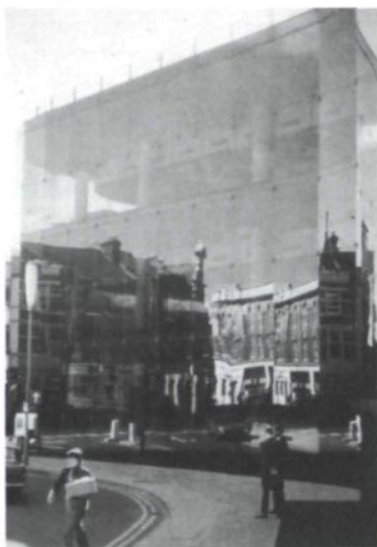
Willis, Faber und Dumas, Ipswich, 1975. Links: Spiegelung der Nachbarbebauung in der Fassade. Mitte: Die Spiegelwand wird abends zur transparenten Glashaut. Rechts: Fassadenschnitt. Verglasungssystem mit Eckhalterung (patch fittings).
