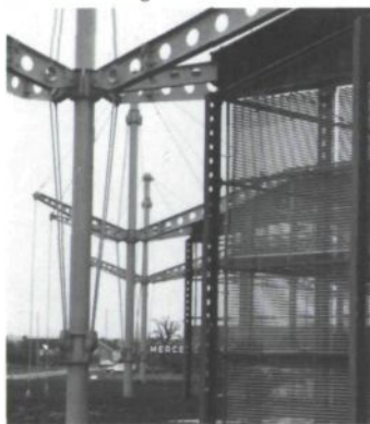
Renault-Centre, Swindon, 1983. Links: Von der Verglasung mit Eckhalterung zur geschraubten Verglasung (planar fittings). Rechts und unten: Fassadendetail mit Verschraubung der Glasscheiben.
