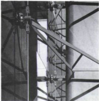
Oben und unten: Fassadenstütze mit Kragarm zur Halterung und Aussteifung.
