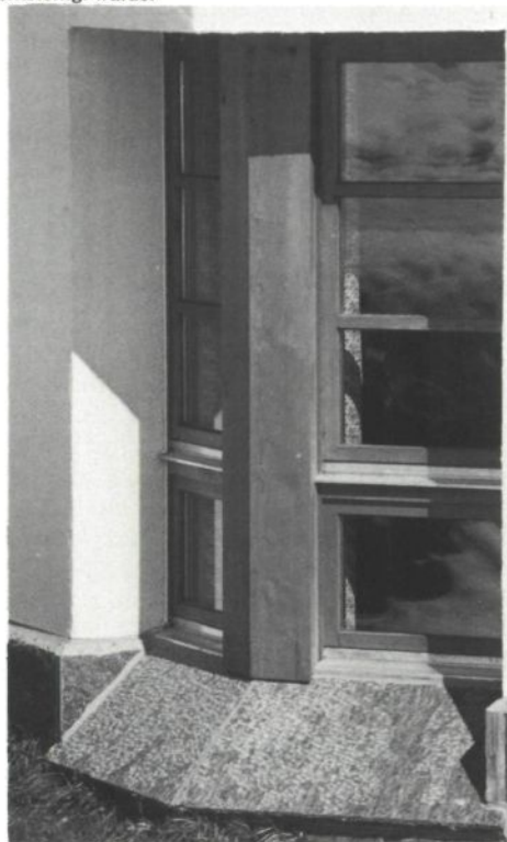
modernes Beispiel für konstruktiven Holzschutz: Fensterdetail mit Holzverblendung, freier Wasserablauf durch starke Anschrägung der Grundplatte.
