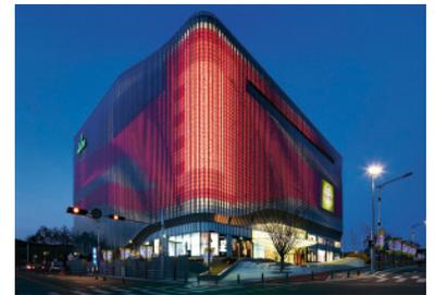
oben: Die 12.600 qm große Fassade des koreanischen Einkaufszentrum Galleria Centercity (Architekt: UN-Studio) ist mit 22.000 LEDs bestückt. Die Fassade ist in verschiedenen Lichtfarben bespielbar. Die Hochleistungs-LED Strahler von Zumtobel sind vollständig in die Fassade integriert.
