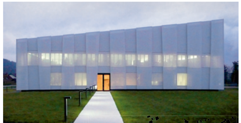
Die Fassade setzt sich aus textilen Verkleidungen aus stehenden trapezförmigen Formaten zusammen. Foto: Jan Bitter
