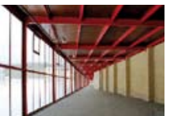
Zustand des gläsernen Gangs 1930, 1990 und 2006 nach der Sanierung durch Winfried Brenne Architekten, Berlin: Blick hinunter zum Hörsaaltrakt. Der Gang ist der wichtigste Erschließungsweg, wie eine verglaste „Straße“ mit Betonfußboden und Bordsteinkanten.
