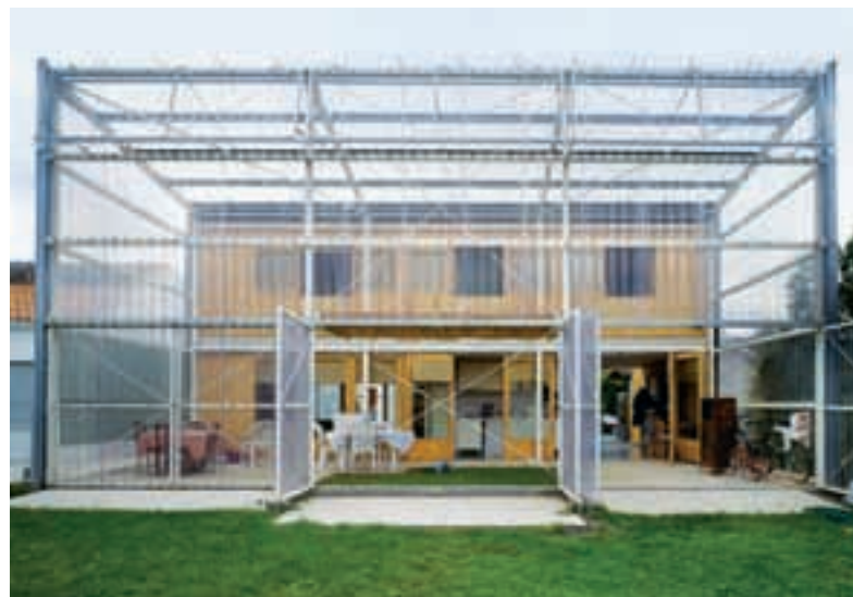
Für das Haus Latapie entsteht aus gängigen Materialien aus dem Baumarkt eine klimatische Pufferzone, die sich die Bewohner individuell aneignen können. Bild oben: Philippe Ruault, unten: Lacaton & Vassal Architectes
