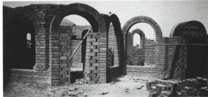
Schalung und Herstellung der Mauerbögen
