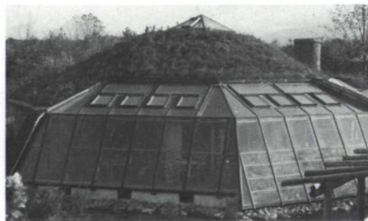
Gegen eine Überhitzung des Wintergartens bei starker Sonneneinstrahlung sind im oberen, geneigten Teil der Verglasung acht Kippfenster eingebaut. Der Zirkulation dienen drei Lüftungsklappen dicht über dem Boden.
