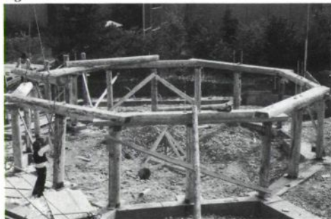
Das Naturhaus im Werden. Auf dem Ringfundament sind die tragenden Rundholzstützen montiert, der erste Dachkranz für die Kuppel von den Zimmerleuten verlegt.
