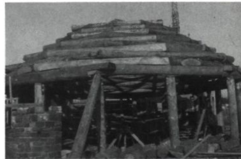
Das Naturhaus im Rohbau. Der Dachkranz aus Rundhölzern wird gefügt.
