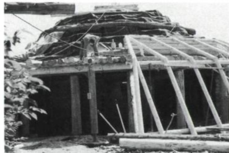
Blick auf die Südwestseite des Naturhauses. Unterbau und Dachfolie für das Wiesendach werden montiert.
