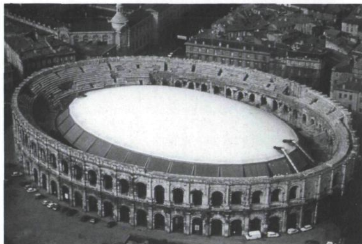
Das Luftkissen über der antiken Arena in Nîmes wird jeweils für die Wintersaison auf- und abgebaut. Es wurde von Schlaich, Bergermann und Partner zusammen mit den Architekten von Labfac/Stuttgart entworfen.
