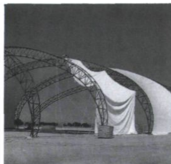
Montage von Hand im Expanderzugverfahren. Reinigung eines Membransegments.
