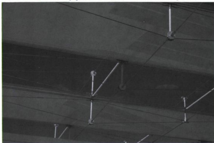
Aluminiumstruktur mit eingespannter Membran. Tribünenüberdachung Monza
