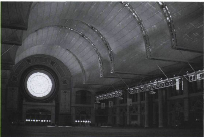
Alexandra Palace London. Transluzente Akustikdecke unter Glasdach.
