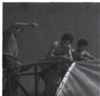
Montage von Hand im Expanderzugverfahren. Reinigung eines Membransegments.
